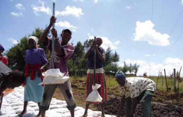
ケニア農村部における土のうによる道直し
